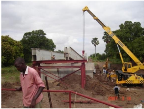
40 Ton rough terrain crane
